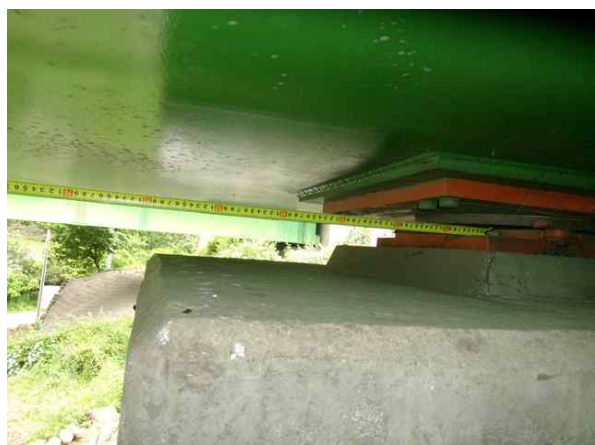
받침장치 연단거리 측정
