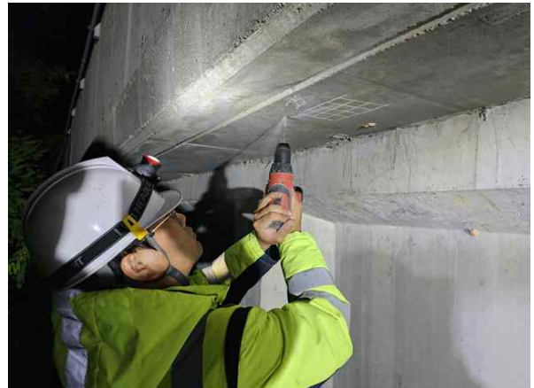
탄산화깊이 측정 현황
