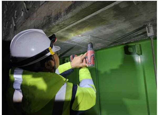
탄산화깊이 측정 현황
