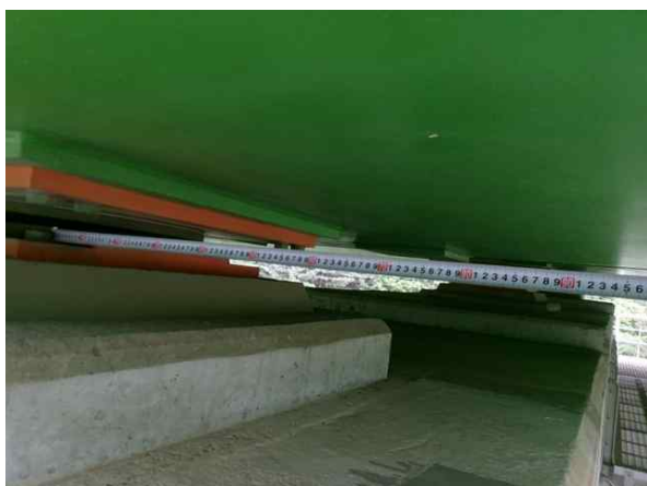
받침장치 연단거리 측정
