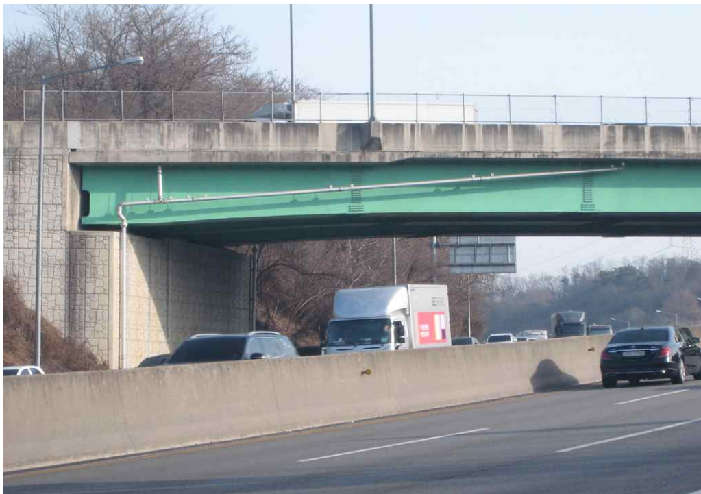
진관IC교 교대 전경
