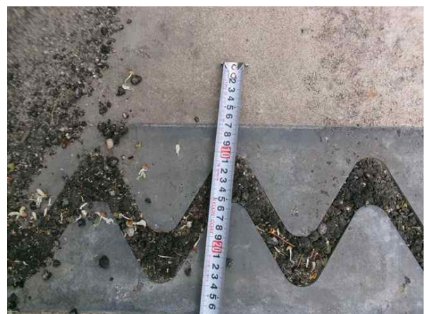
신축이음 이동량 측정
