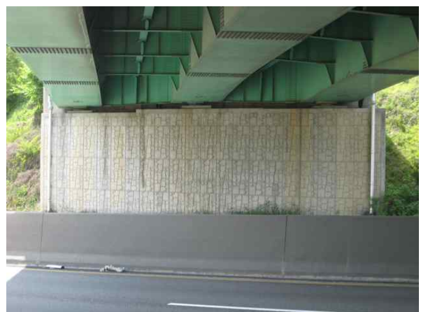
교대 A2 전경
