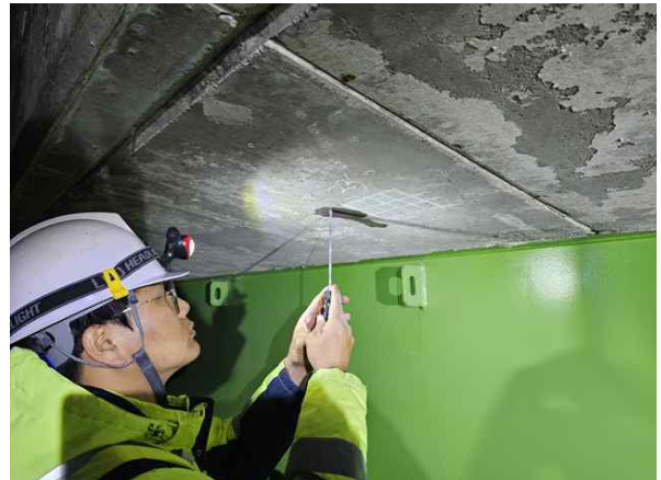
탄산화깊이 측정 현황
