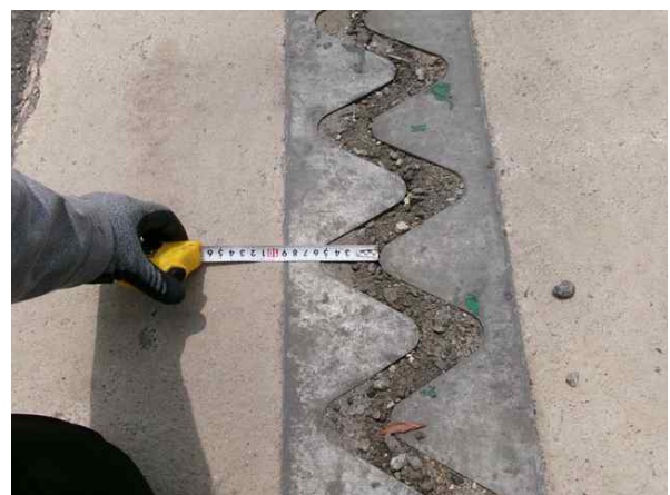
신축이음 이동량 측정
